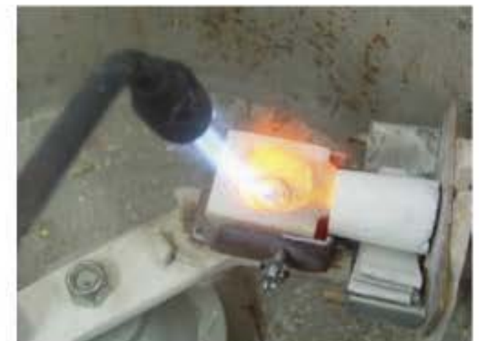
Figura 8.11 – Maçarico usado para fundir a liga metálica, que pode ser do tipo gás-ar ou gás-oxigênio.
